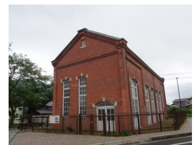
旧京都電燈古市変電所
