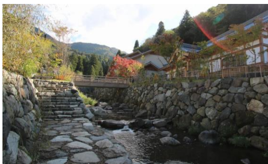
修景整備された永平寺川
