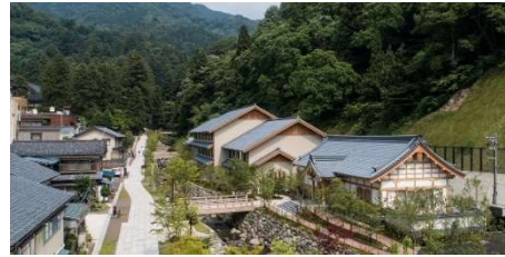
再整備された旧参道と永平寺川、新設された親禅の宿「柏樹閣」
