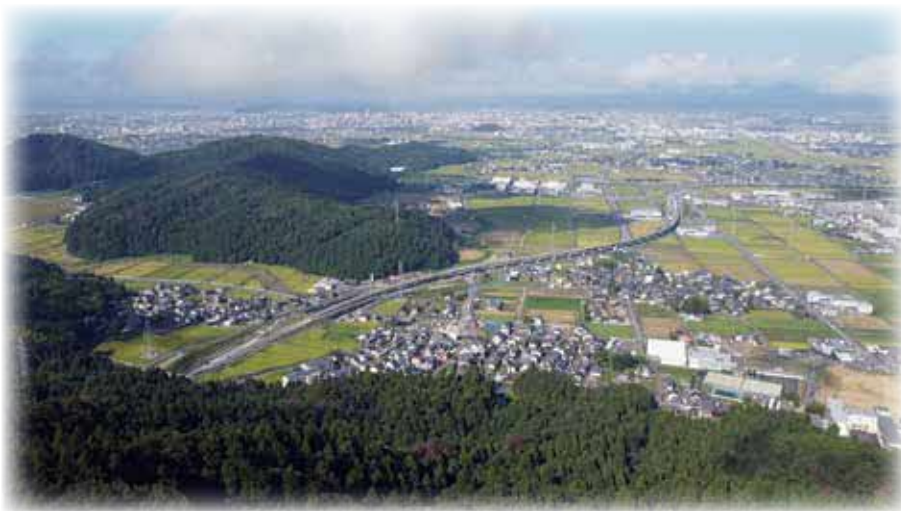
中部縦貫自動車道
