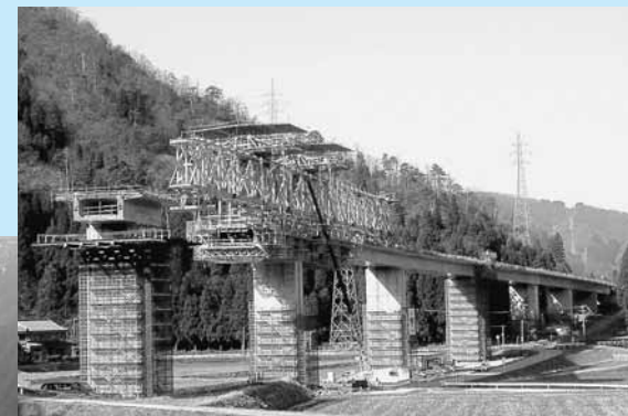
橋梁上部工事が進む「吉峰高架橋」
