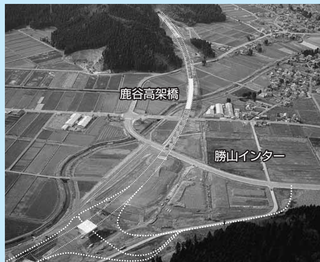
工事が進む「鹿谷高架橋、勝山インター」
