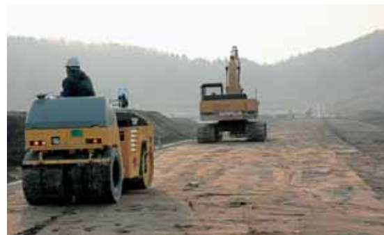
町道吉野74号線改良工事
