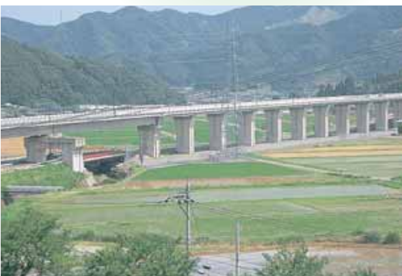
中部縦貫自動車道
