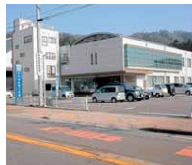
永平寺町商工会館
