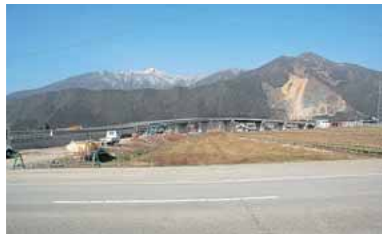
上志比跨線橋
