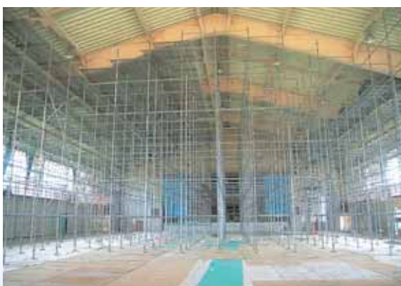
耐震補強工事（松岡中学校）
