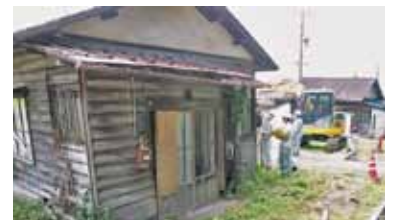
解体予定の町営住宅
