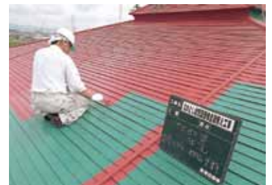
幼保園リフレッシュ工事
