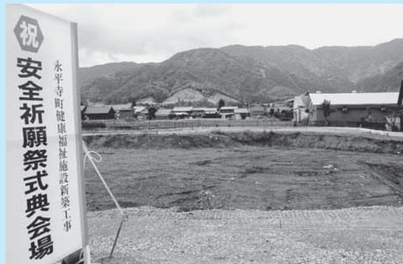
上志比地区清水にある建設予定地
