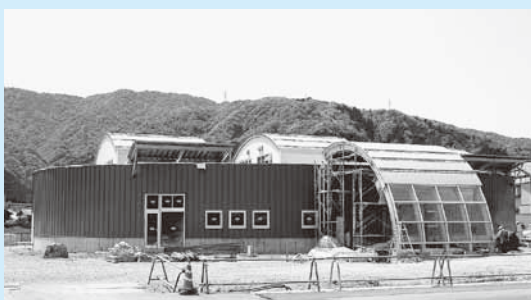
工事施工状況写真（5月10日撮影）
