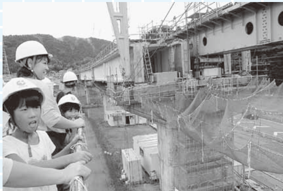
高所作業車に乗って現場見学する参加者
