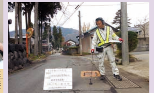
漏水調査業務委託
