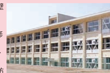
松岡小学校南校舎棟完成
